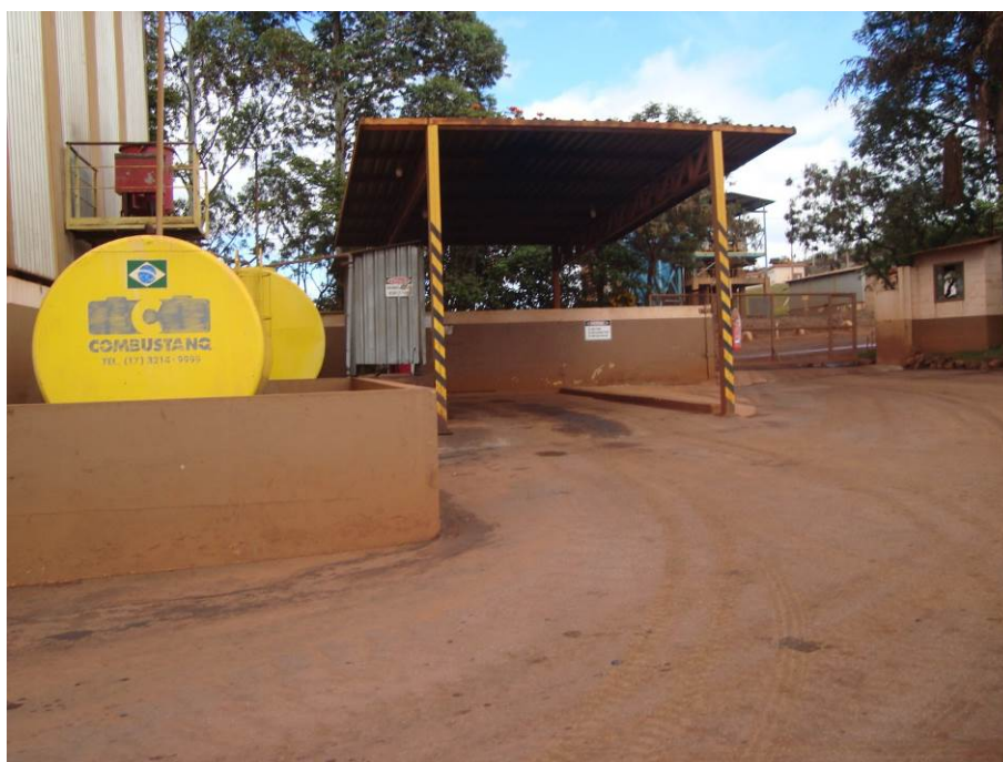
Figura 66 - Posto de abastecimento, observando-se os tanques com a devida caixa de proteção.
