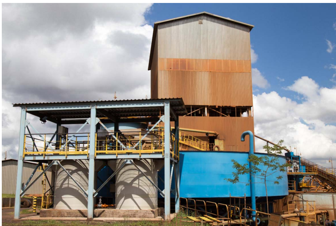
Figura 61 - Espessador de rejeitos que será interligado aos filtros para desaguamento do rejeito.
