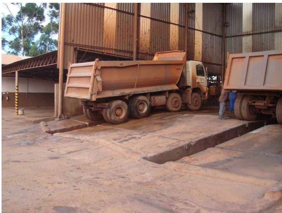
Figura 67 - Rampa para lavagem de veículos cujos efluentes oleosos são direcionados para caixa separadora de água e óleo.
