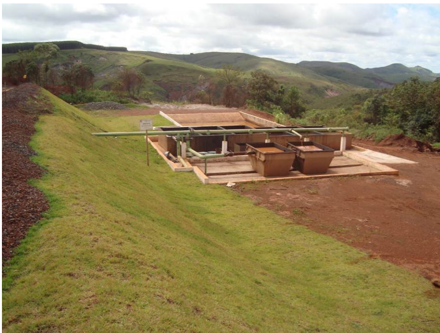
Figura 69 - Sistema separador de água e óleo.
