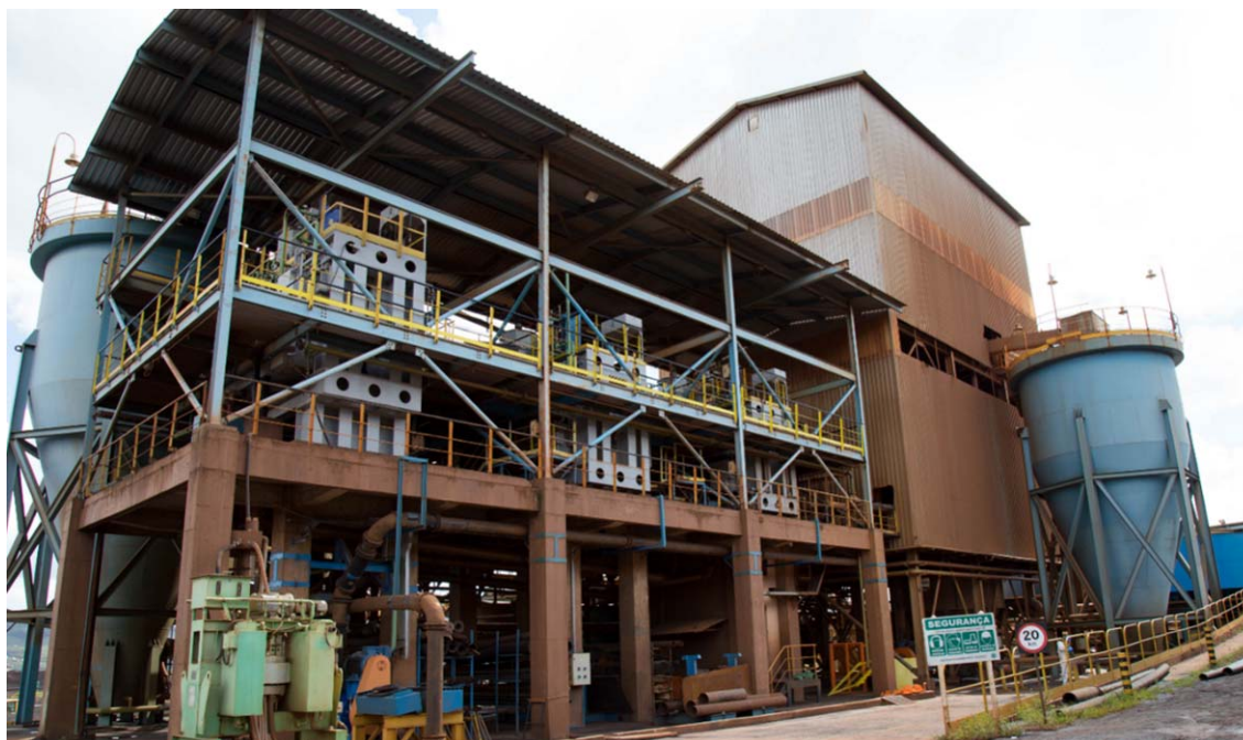
Figura 59 - Concentradores Magnéticos e Prédio de Espirais que compõe a concentração de sinter feed . A direita observa-se o espessador de coluna EP-01.
