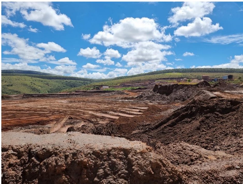
FOTO 46 – Trecho interno de retomada na ombreira direita da barragem B1. Nesta região evidenciam-se, em diversos pontos, que a retomada já alcançou a superfície topográfica natural.
