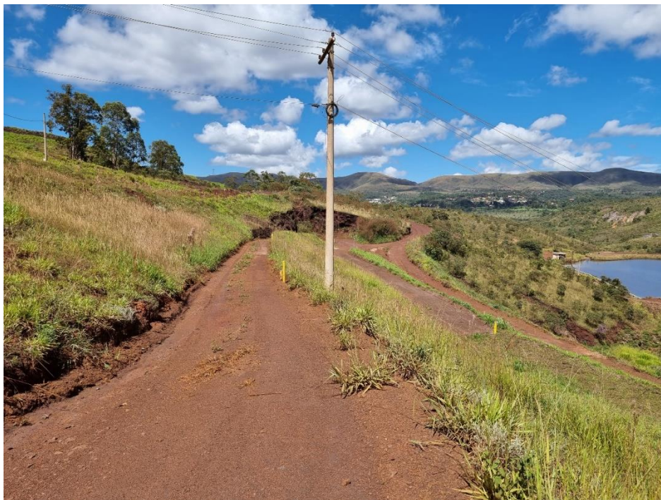
FOTO 34 – Banco Elev. 1250 m. Inexistem indícios de movimentação ou processos erosivos superficiais. Com a ocorrência do período chuvoso a vegetação apresentou desenvolvimento e deverá ser objeto de poda.
