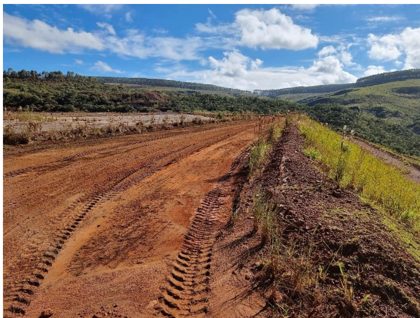
FOTO 60 – Crista da barragem B4, posicionada na cota El. 1240 m. A conformação geométrica não indica nenhum risco de instabilização. As rotineiras investigações e monitoramentos realizados vem confirmando as observações de normalidade de comportamento.
