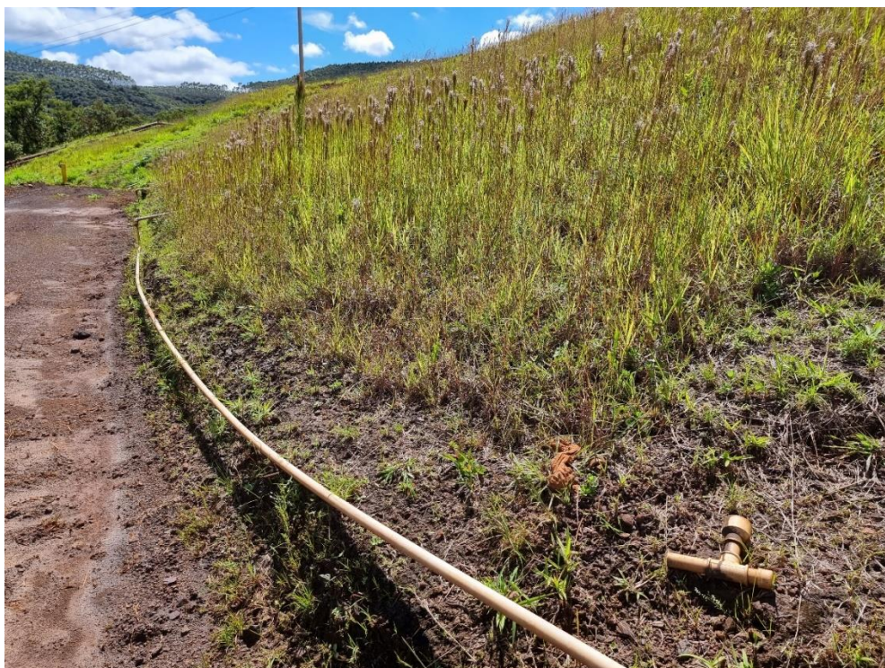
FOTO 38 – Detalhe das linhas de drenos horizontais profundos, interligados e com vazão monitorada por hidrômetro.
