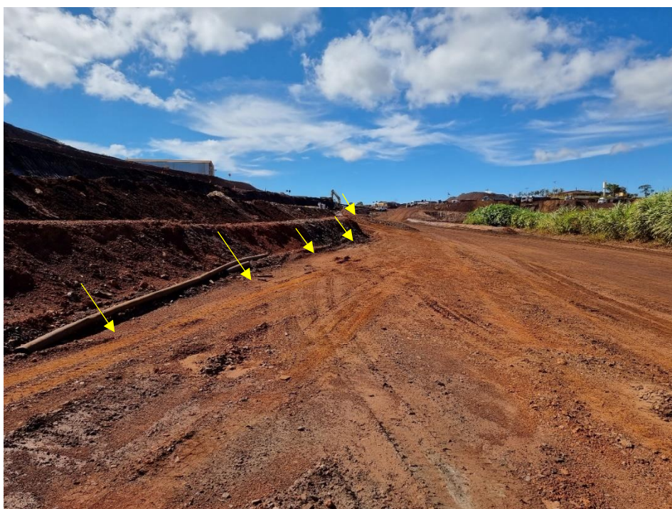
FOTO 06 – Outra vista de trecho na ombreira direita da estrutura, Elev. 1277 m, em região anteriormente recoberta com rejeitos e já geometrizada. Na região assinalada com setas, encontra-se o alinhamento aproximado do dreno de ombreira construído.
