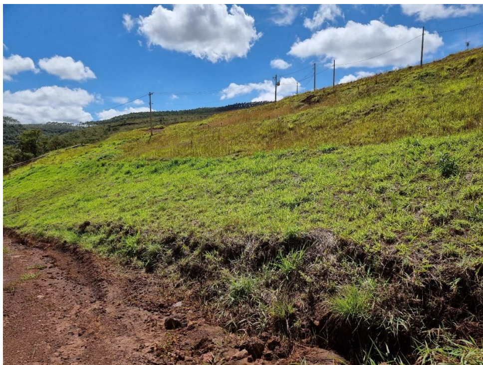
FOTO 40 – Vista do talude central da estrutura a partir da Elev. 1230. Os taludes não apresentam processos erosivos superficiais, inexistindo a ocorrência de surgências.
