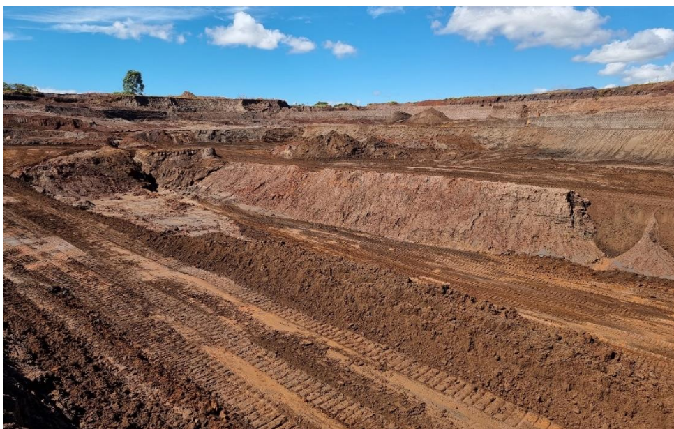
FOTO 18 – Trecho em escavação para redivisão da estrutura em B1 e dique da B1. A instrumentação disponível e serviços de geofísica indicam que o dique da B1 se encontra seco, sem variações de poropressão. Neste sentido a intenção é separar trechos já secos da estrutura. Com a construção do dreno de ombreira a entrada de fluxos de água realimentando rejeitos deverá ser reduzida, favorecendo menores poropressões.
