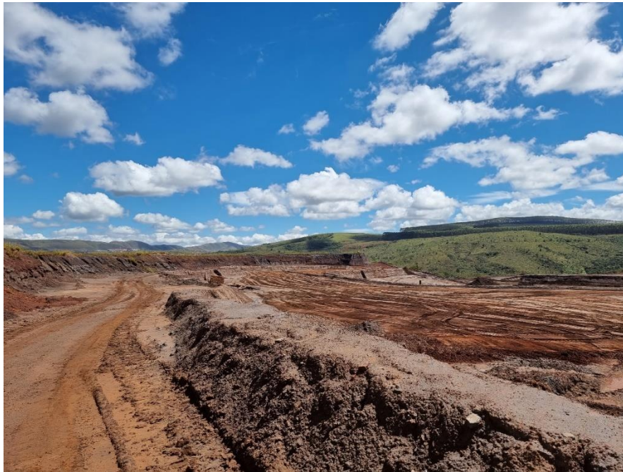
FOTO 45 – Porção remanescente da barragem B1, na região denominada dique da B1. Os avanços nesta região são tipicamente realizados em período concentrados de chuva, por tratar-se de região bastante seca e com boa acessibilidade.
