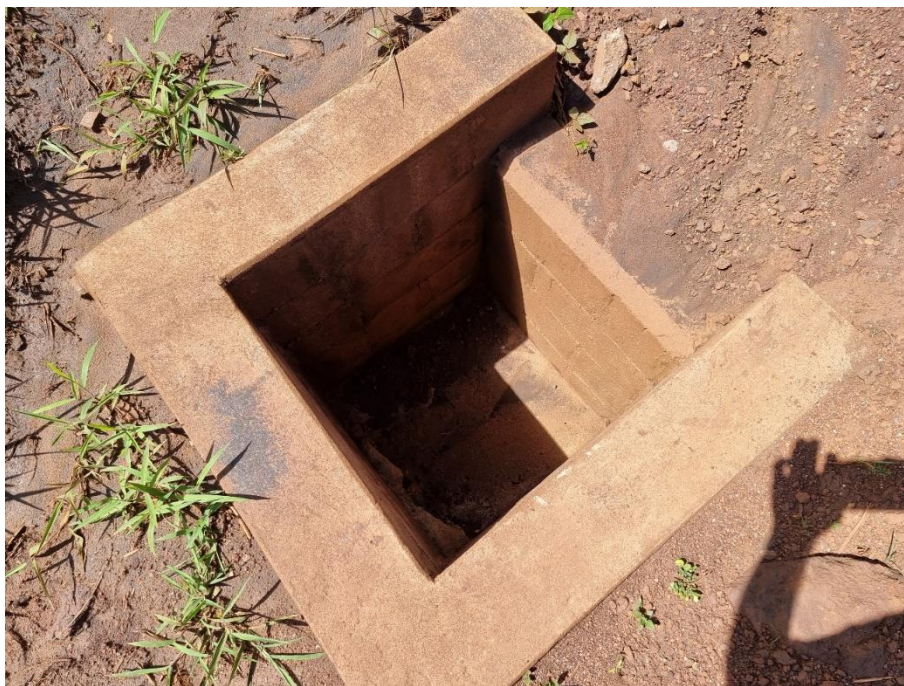
FOTO 41 – Caixa de passagem posicionada na cota El. 1230 m. As caixas de drenagem foram vistoriadas e encontram-se limpas.
