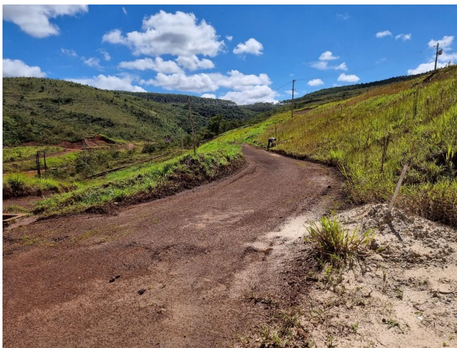
FOTO 36 – Banco Elev. 1240 m. Nesta região existem drenos horizontais profundos, instalados em 2012, durante o período operacional da estrutura, para controle de seus níveis geotécnicos. Mesmo após a paralização de qualquer lançamento de rejeitos na estrutura e a construção de drenos de ombreira esta região apresenta fluxos perenes.
