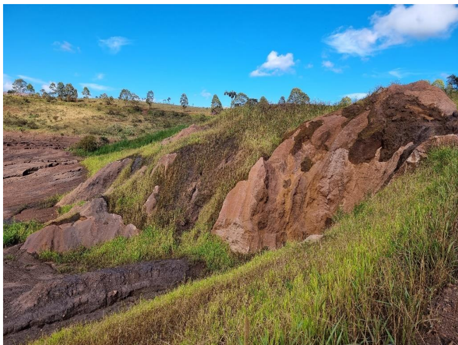
FOTO 62 – Conforme recomendação anterior, o antigo vórtex foi objeto de recomposição, sendo geometrizado e revegetado. Deste então os monitoramentos não apresentam nenhum sinal de reativação do processo de formação do carste.
