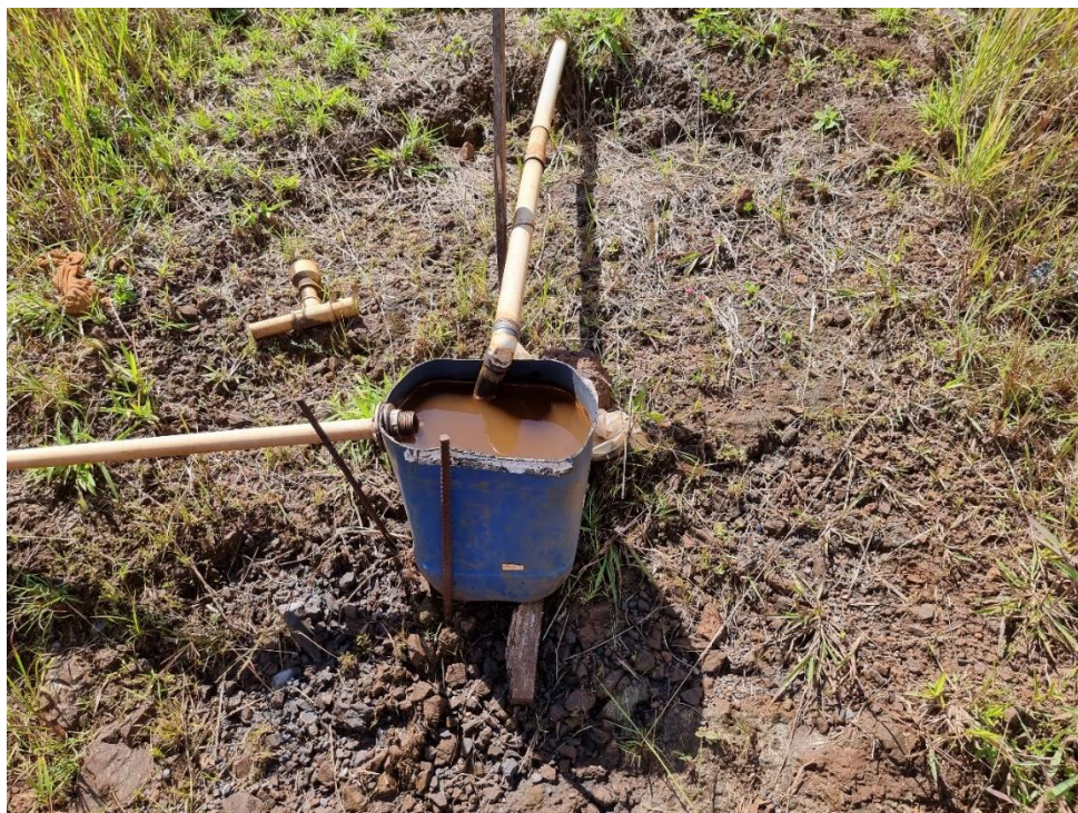
FOTO 37 – Detalhe de caixa de saída instalada em dreno horizontal profundo. A intenção destas caixas é o monitoramento da presença de sólidos nestes dispositivos de drenagem interna.
