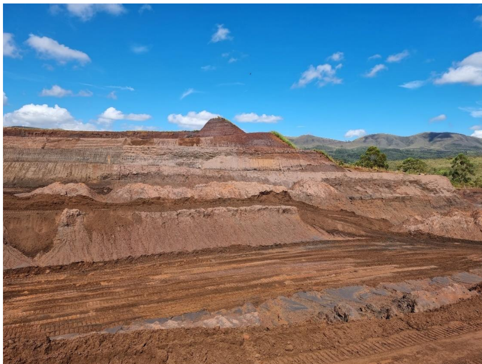
FOTO 17 – Porção central da barragem, evidenciando a inexistência de surgências nesta região. A intenção nesta região é continuar a escavação até atingir a fundação, construindo um dreno de ombreira dividindo a B1 da porção denominada dique da B1. É esperado observação de maior poropressão nas proximidades com a fundação.
