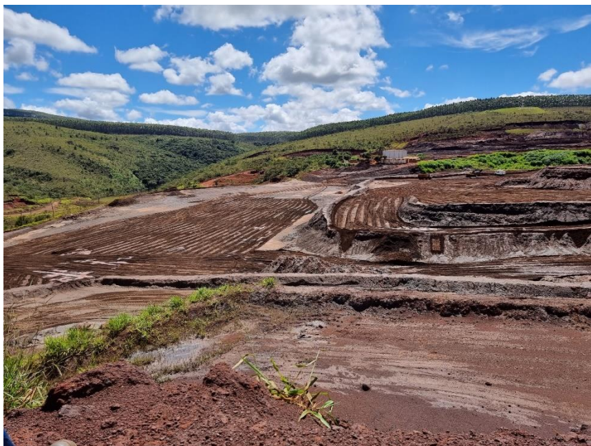
FOTO 47 – Vista geral da barragem B1, em retomada, a partir da ombreira esquerda. Evidencia-se a formação de praças amplas, com ângulo geral de retomada bastante suave, e com redução progressiva das tensões cisalhantes para os taludes remanescentes.
