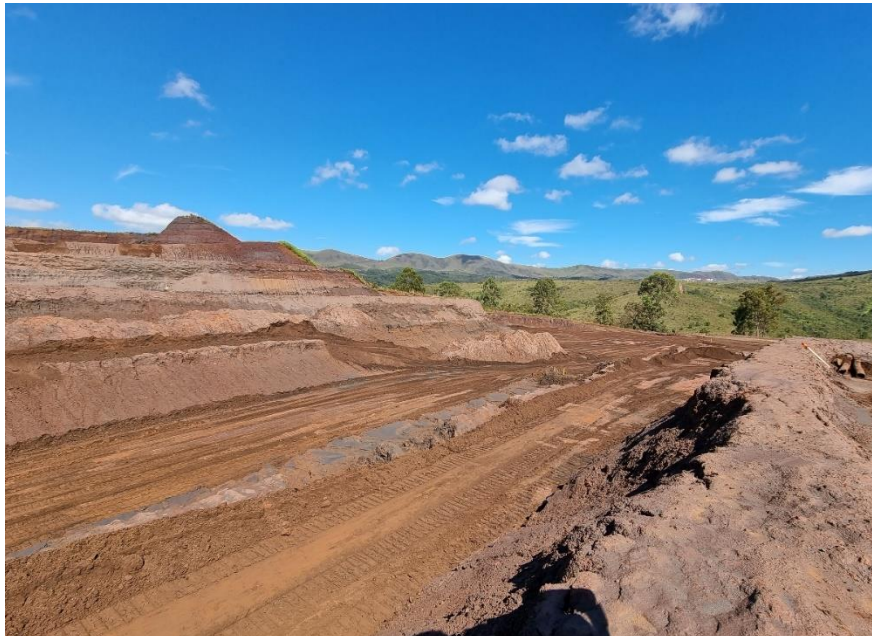
FOTO 19 – Porção central da estrutura, observando-se, ao fundo, eucaliptos plantados em terreno natural. A escavação deverá ter sequência até que seja atingido o terreno natural, atingindo, aproximadamente, o nível dos eucaliptos.
