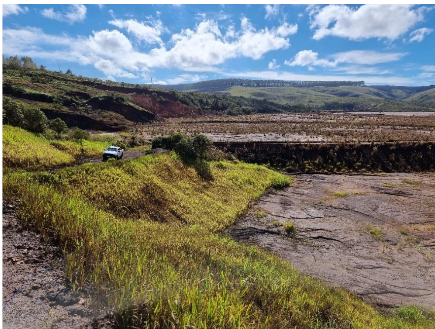
FOTO 64 – Reservatório encaixado na ombreira esquerda da estrutura, sem nenhuma zona de acúmulo de água. Em primeiro plano, serviço de recomposição da região do vórtex.
