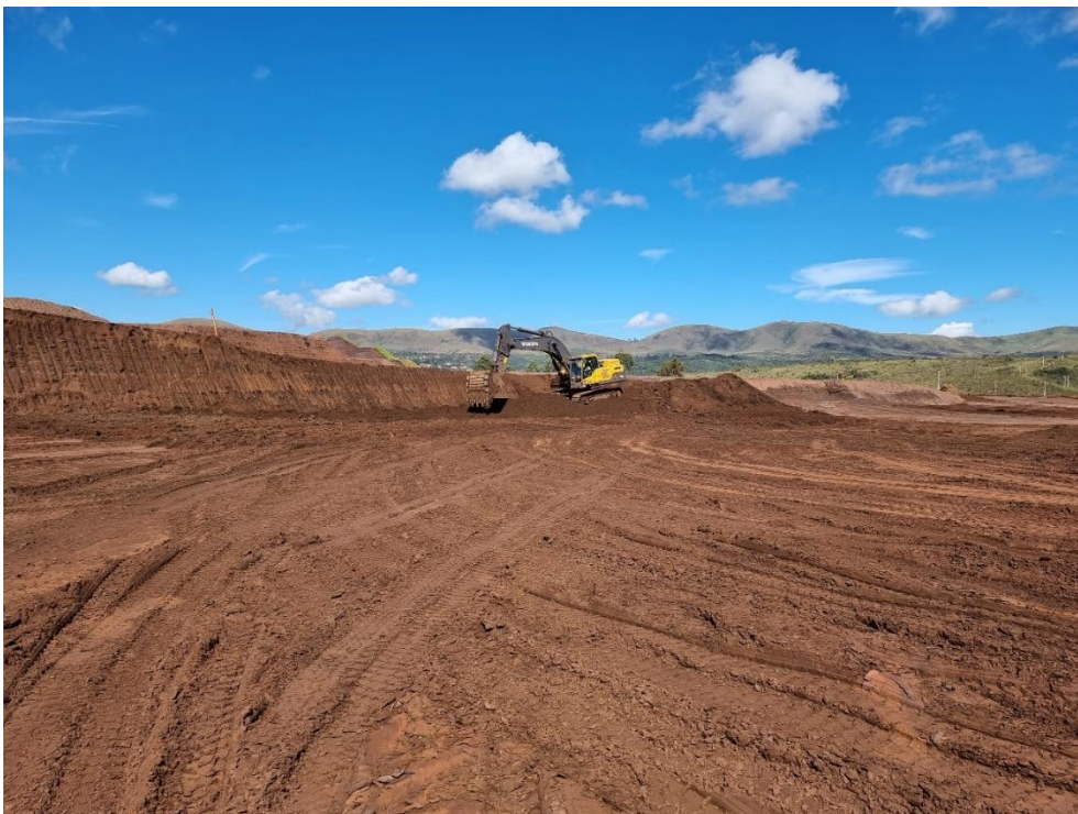
FOTO 10 – Operação da escavadeira, removendo o rejeito e preparando a face do talude de retomada. Nesta região não é identificada a geração de poropressão na utilização de equipamentos, o que é mais comum ocorrer nas proximidades com a fundação.
