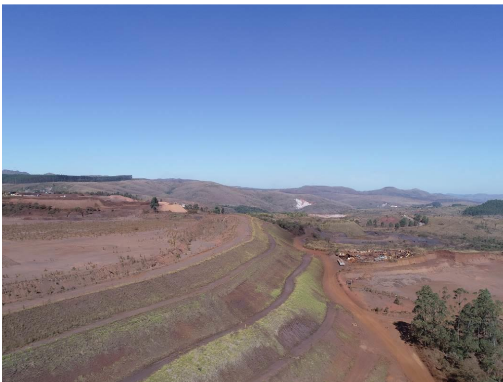
Maciço da barragem B1, ombreira esquerda. Ao fundo, área da tromba. Nestas áreas os trabalhos de retomada ainda não avançaram, mantendo configuração muito similar a configuração final da estrutura.
