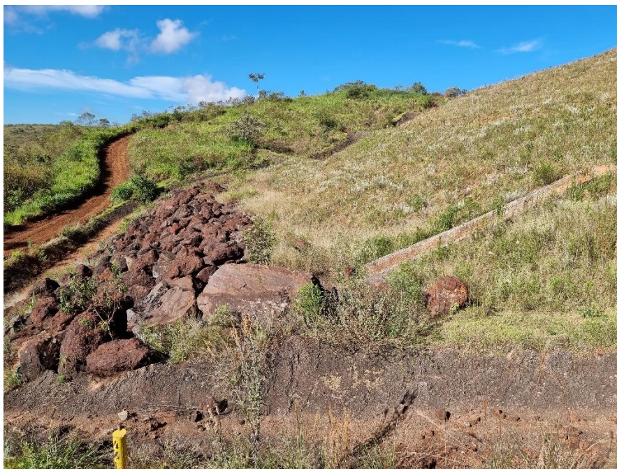
FOTO 54 – Em primeiro plano, instrumento B4PZ01. Trata-se do instrumento com maiores variações piezométricas do conjunto de instrumentos da estrutura, com variações típicas no final do período chuvoso. Atualmente este instrumento está com leituras em 9 m de profundidade, indicando que as variações estão associadas a mudança de poropressões na circulação pela fundação, sem ligação com o rejeito. O topo do enrocamento está posicionado na cota El. 1202 m.
