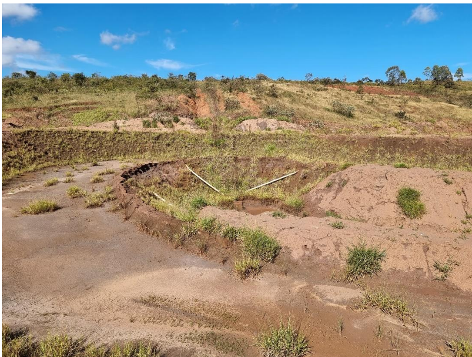
FOTO 65 – Detalhe do ponto de adução do vertedouro, em flauta. A adutora encontra-se limpa e sem riscos de obstruções. Não há qualquer indicio de risco estrutural da flauta extravasora.
