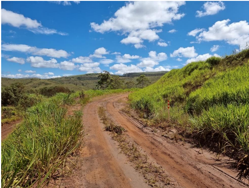
FOTO 43 – Banco na Elev. 1263 m, na ombreira esquerda da barragem. Nesta região inexistem indícios de movimentação, surgências ou processos erosivos superficiais. A vegetação gramínea encontra-se com necessidade de poda.
