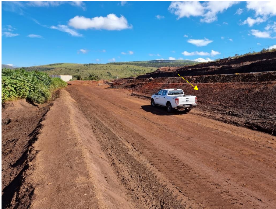
FOTO 05 – Ombreira esquerda da estrutura. Nesta região, anteriormente recoberta com cerca de 20 m de rejeito, o processo de retomada já foi concluído, com exposição de argila vermelha. Em diversos locais investigados evidenciou-se grande espessura deste solo argiloso, caracterizado como solo residual de filito dolomítico, especialmente na ombreira direita.
