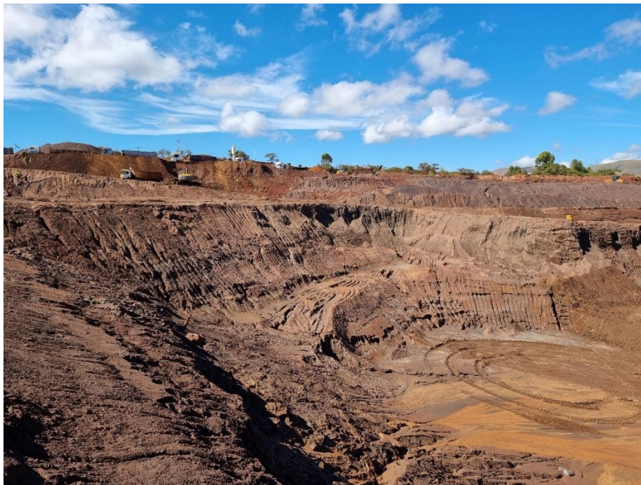
FOTO 03 – Porção já encaixada em terreno natural na escavação da barragem de rejeitos.
