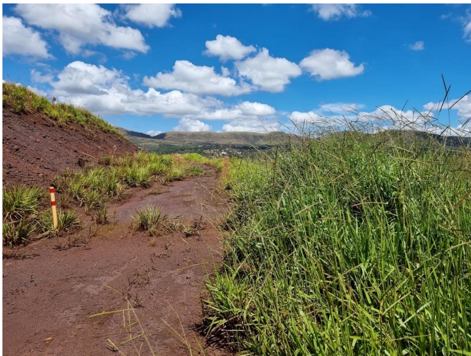
FOTO 50 – Talude remanescente na ombreira esquerda da estrutura, Elev. 1282 m. Nesta região observa-se desenvolvimento da vegetação, que necessita de poda. A necessidade de poda, destaca-se, não foi considerada impeditiva para realização da vistoria.
