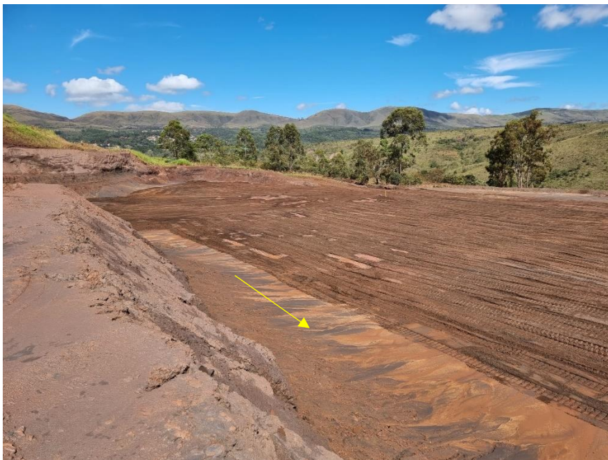
FOTO 20 – Banco em retomada na Elev. 1262 m, já nas proximidades de atingir o limite final da barragem de rejeitos. O acúmulo de materiais no pé do talude (seta) é resultando de carreamentos localizados dos taludes expostos em rejeito, material não coesivo. De modo geral não são identificados processos erosivos nas faces dos taludes.
