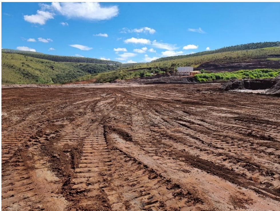
FOTO 16 – Outra visada da praça de retomada da barragem. Ao fundo, galpão de sondagem assentado sobre terreno natural e não inserido na ZAS da estrutura.
