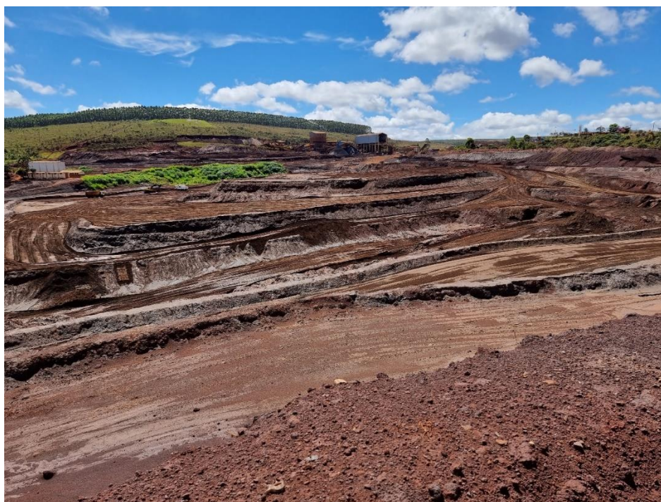
FOTO 48 – Escavação central da barragem B1, dividindo a porção remanescente da ombreira direita e da ombreira esquerda (dique da B1). Ao fundo, planta de concentração no local denominado Tanque Seco.
