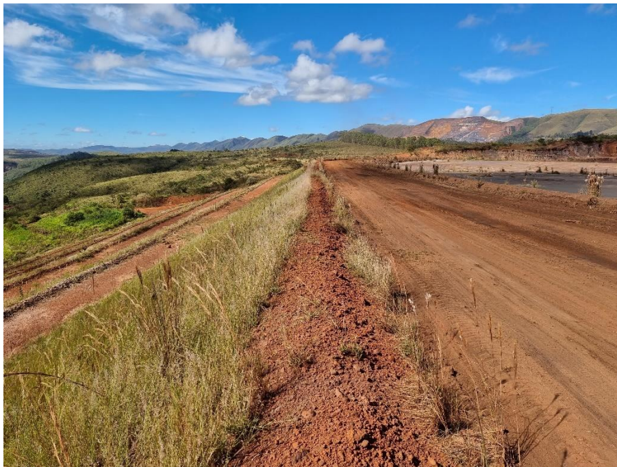
FOTO 67 – Talude de jusante da estrutura avistado pela ombreira direita da barragem B4. Não há evidências de riscos identificadas ao longo de toda a estrutura.
