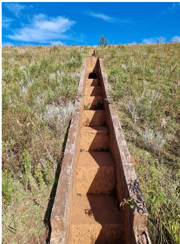
FOTO 57 – Detalhe de escada de descida d'água utilizada para direcionamento da drenagem superficial na porção central da barragem B4. A estrutura encontra-se limpa e sem indícios de mal funcionamento.
