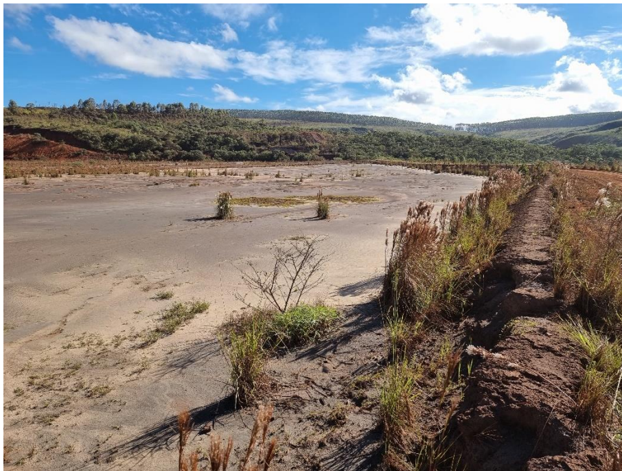
FOTO 61 – Reservatório da barragem B4, nas proximidades de sua crista. Já há alguns anos não existe lançamento de rejeitos no reservatório da estrutura e, com efeito, o processo de adensamento dos rejeitos parece ter se encerado. Investigações apontam para a existência de rejeitos secos na região, confirmados pela instrumentação implantada no interior do reservatório.
