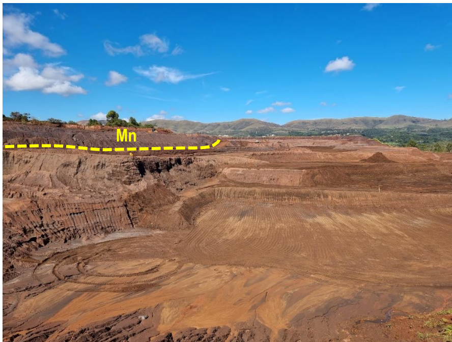
FOTO 04 – Outra vista da barragem B1, em retomada adiantada. A linha divisória delimita, de forma aproximada, porção aflorante em manganês (material exposto de coloração mais escura), em porção região já retomada da barragem B1. Destaca-se que os taludes de retomada vêm tipicamente sendo conduzidos com pequena elevação, o que favorece a proteção à ocorrência de processos erosivos superficiais.
