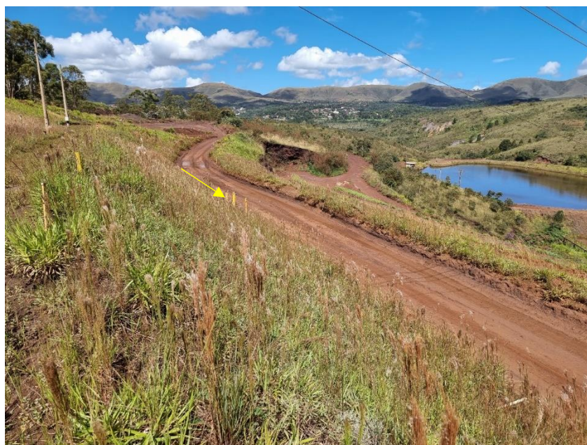
FOTO 32 – Banco na Elev. 1250 m, com destaque para os instrumentos B1PzC04a, B1PzC04b, B1PzC53, B1PzC54 (seta). Na ombreira são identificados materiais associados à fundação.
