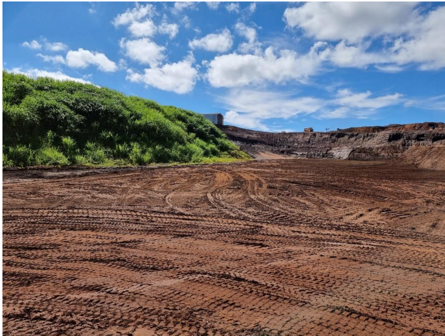
FOTO 09 – Foto da ombreira direita, em nível inferior ao da fotografia atual, El. 1264 m. Na praça apresentada inexistem surgências, com a praça apresentando-se operacional. A intenção é a abertura de um novo dreno de ombreira nas proximidades do talude. O trecho revegetado está em terreno natural argiloso.
