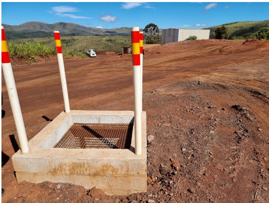
FOTO 07 – Caixa de passagem construída na ombreira direita para concentrar os fluxos do dreno de ombreira.
