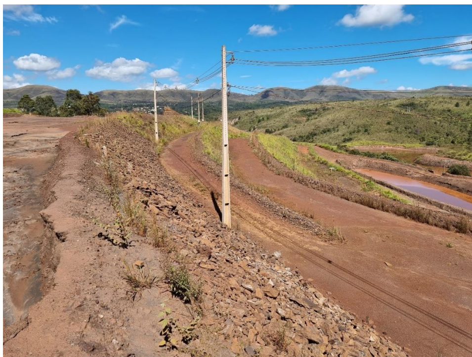
FOTO 24 – Talude remanescente da barragem B1, Elev. 1257 m a 1262 m (5m de altura), com reforço de itabirites compactos. Nesta região, em função da proteção rochosa, inexistente qualquer evidência de processos erosivos. Os demais taludes encontram-se adequadamente vegetados e não apresentam processos erosivos superficiais.
