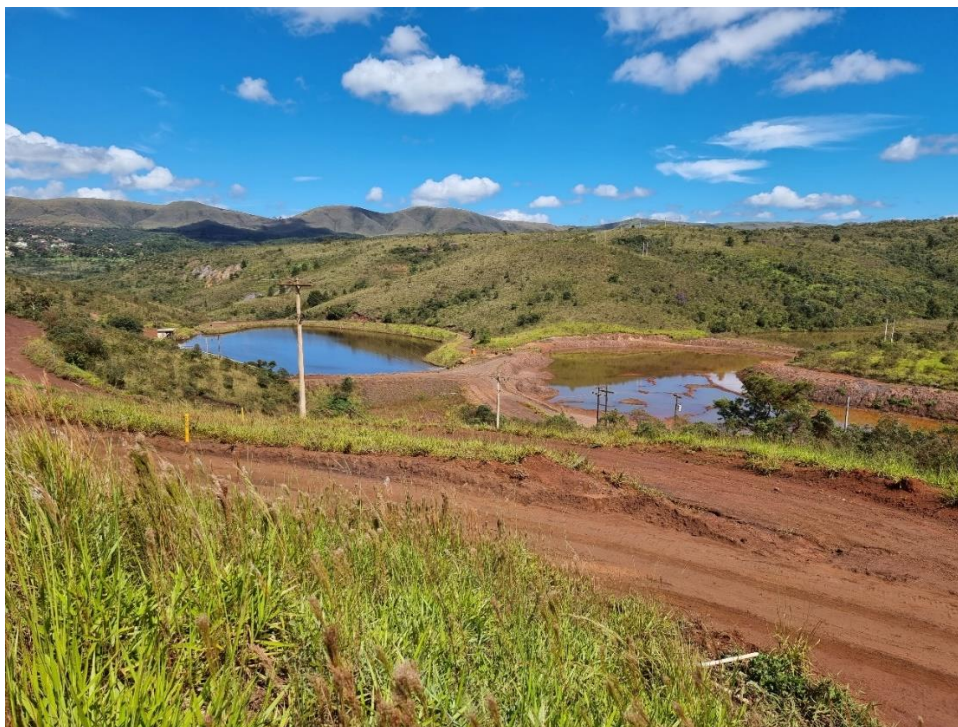
FOTO 29 – Diques B2 e B3 ao fundo da barragem B1. As drenagens da barragem B1 são direcionadas para estas duas estruturas, utilizadas para controle de sedimentos em tributário do Ribeirão do Silva.
