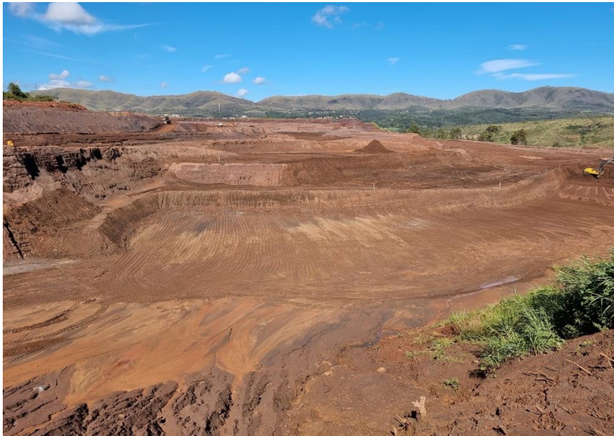
FOTO 01 – Vista, a partir da ombreira direita da estrutura, do antigo reservatório da estrutura escavado, em alguns locais em mais de 30 m. A praça remanescente encontra-se seca, evidenciando a inexistência de processos de percolação nas porções já expostas do rejeito.
