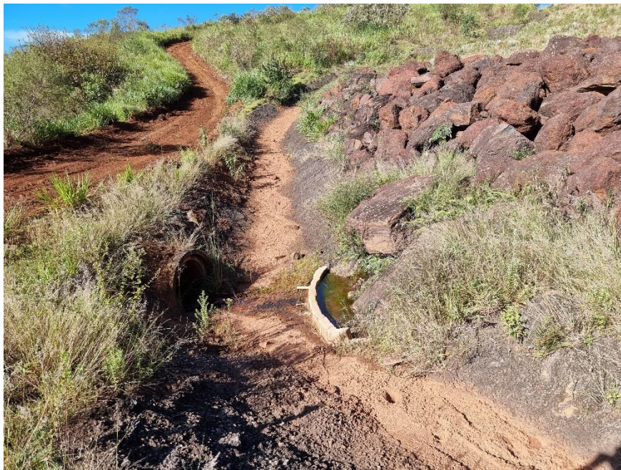
FOTO 53 – Detalhe da saída do dreno de fundo da estrutura, com gotejamento de água, em vazão reduzidíssima, acompanhada por método volumétrico.
