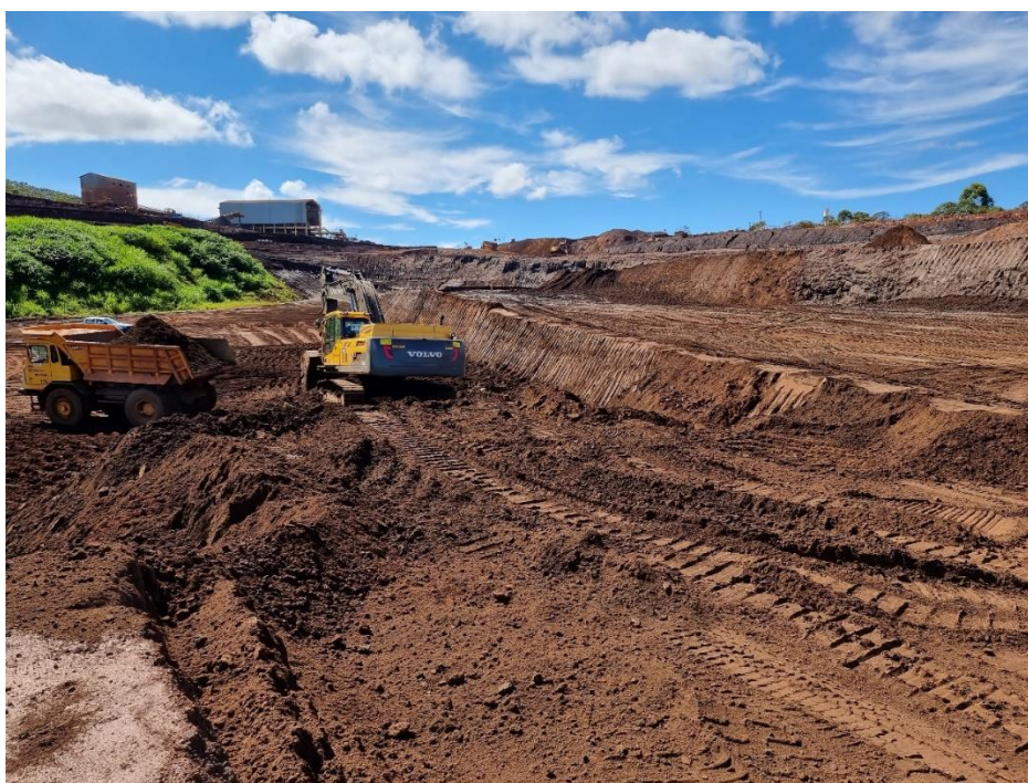
FOTO 12 – Detalhe da operação de escavação e carregamento mecânico realizado para retomada da barragem B1. Destaca-se que todo o trabalho de retomada nesta estrutura foi realizado com a utilização combinada de escavadeiras/carregadeiras e caminhões. Como equipamentos de apoio destaca-se o uso de motoniveladoras, tratores e caminhões pipa.
