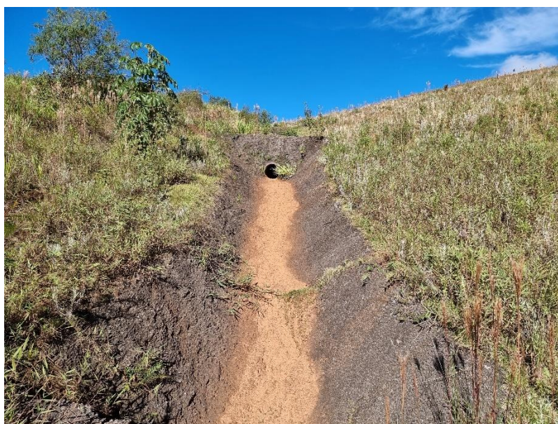
FOTO 58 – Canal lateral de drenagem superficial instalado na ombreira direita da barragem B4, também para direcionamento das drenagens superficiais da estrutura. Há indícios de fluxo raso, sem obstruções.
