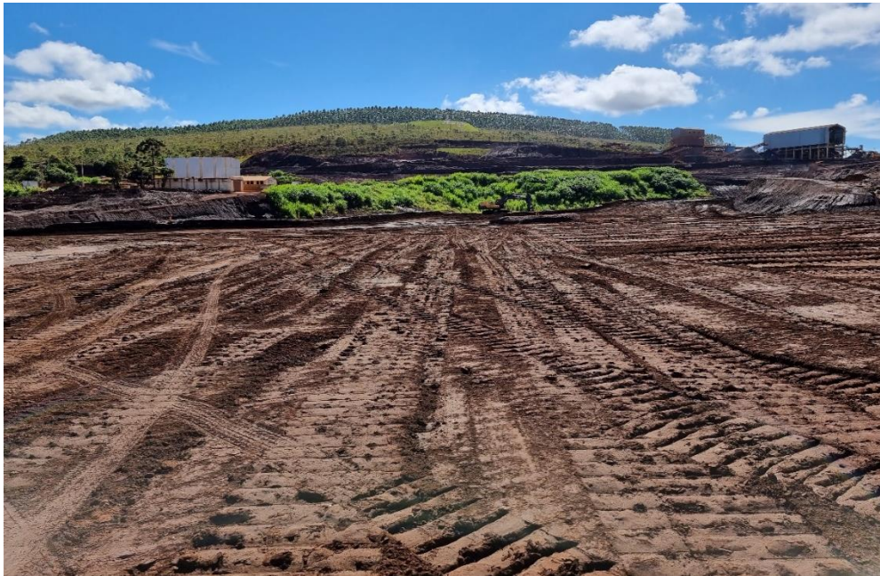
FOTO 15 – Praça de retomada da barragem, observando-se, ao fundo, a ombreira direita da estrutura, com redução da coluna de rejeitos em cerca de 20 m. As praças remanescentes são amplas, garantindo redução de cargas cisalhantes graduais. Inexistem indícios de riscos nas praças.
