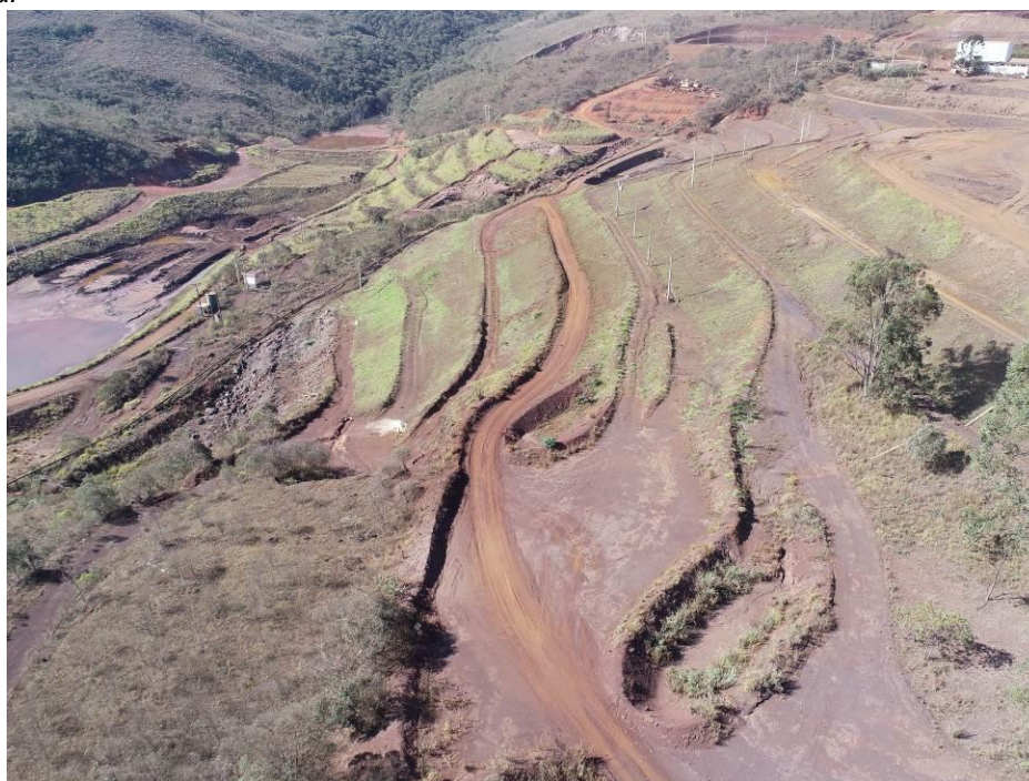
Vista de detalhe do pé da estrutura, em sua porção central. Os blocos de enrocamento posicionados em seu pé foram parte de obras de reforço realizados em 2012, incluindo ainda a perfuração de drenos horizontais e de poços tubulares. Parte destas estruturas permanece com fluxo de água perene.
