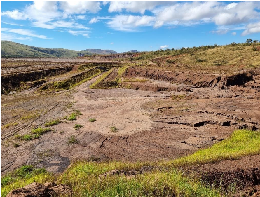
FOTO 63 – Vista geral do reservatório a partir do antigo vórtex da barragem B4, posicionado em sua porção de montante. Verifica-se que o reservatório não apresenta acúmulo de água, com a adução do vertedouro (seta) posicionado em cota bastante inferior à crista e, com efeito, garantindo borda livre ampla para o trânsito das precipitações críticas de projeto.
