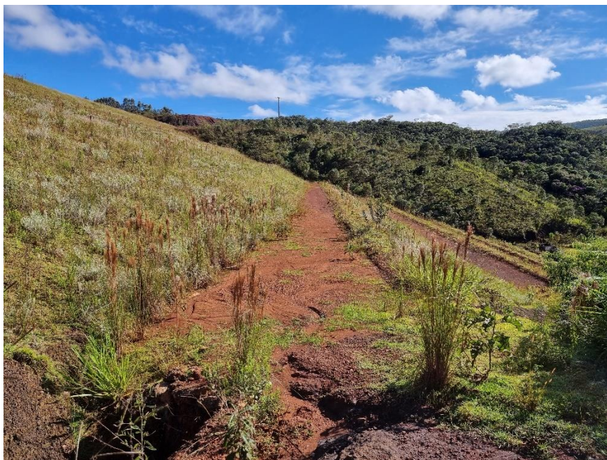
FOTO 59 – Banco intermediário da barragem B4, El. 1220 m. Não há qualquer indicio de instabilização, particularmente a inexistência de indícios de movimentação e/ou trincas, bem como identifica-se que a estrutura encontra-se devidamente protegida para ocorrência de processos erosivos superficiais. A vegetação apresenta desenvolvimento e deverá ser objeto de poda.
