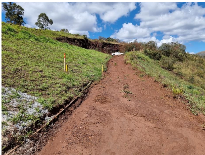
FOTO 39 – Banco Elev. 1236 m, no pé da barragem B1, observando-se, ao fundo, talude em fundação. Neste banco também existem drenos horizontais profundos originalmente instalados para a operação da estrutura. Estes drenos também têm fluxos perene e são monitorados por hidrômetro. Na rampa observa-se a ocorrência típica de processo erosivo raso, o que foi corrigido com a melhoria do sistema de drenagem superficial.
