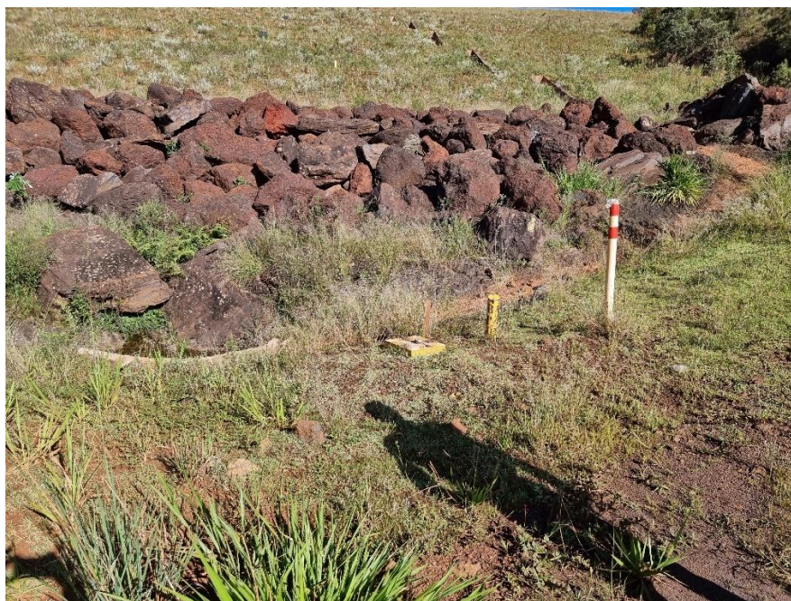
FOTO 52 – Detalhe do pé da estrutura, em enrocamento, instrumentado pelo piezômetro B4PZ05. Tipicamente este instrumento apresenta leitura seca, recentemente com elevações em 1,5 m em sua leitura, 13,5 m abaixo do nível topográfico. Existem consideráveis evidências de que o processo de percolação principal ocorre em profundidade.
