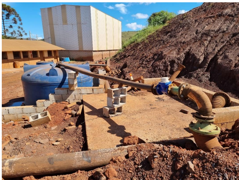
FOTO 08 – A saída dos fluxos da caixa de passagem é monitorada por hidrômetro dedicado, descarregado em tanque de PVC, e seguindo para a drenagem natural na descarga da caixa australiana, posicionada à sua jusante. Coordenadas: 611689.7 m E, 7760481.7m N, Elev 1276m.
