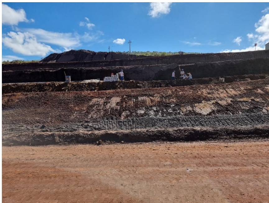
FOTO 02 – Trecho na ombreira direita da estrutura, escavado, com exposição de materiais de fundação na parede remanescente da estrutura. Nesta região foi escavado canal, preenchido com materiais drenantes, brita e areia, recompondo o sistema de drenagem interna originalmente inexistente na estrutura. Este instrumento vem funcionando eficientemente para evitar percolação de água nova para as porções remanescentes da estrutura.
