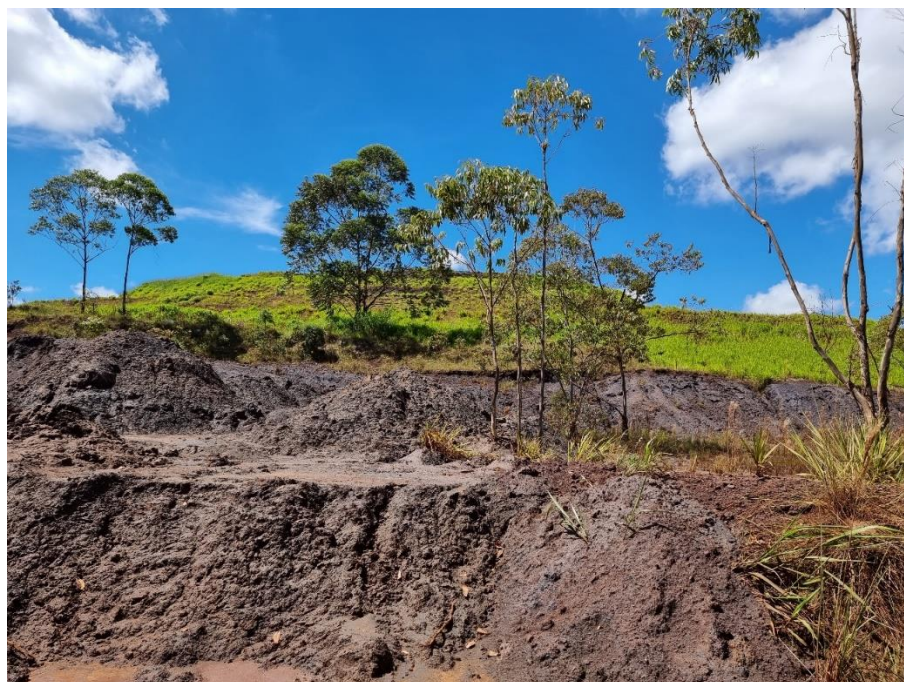
FOTO 42 – Porção a jusante do dique da B1, na ombreira esquerda da estrutura, observando-se a presença de manganês aflorante nesta porção. Na ombreira esquerda (dique B1) as atividades de retomada vêm sendo postergadas, considerando os seguintes condicionantes: (a) a instrumentação evidencia que os rejeitos nesta região não estão saturados, com saturação da fundação em profundidade; (b) garante barreira à comunidades da região.
