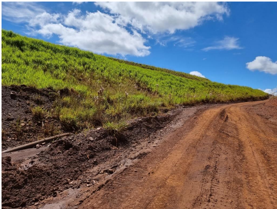
FOTO 44 – Ombreira esquerda da barragem B1. Nesta região o processo de retomada não foi iniciado, mantendo-se a observação da inexistência de processos erosivos superficiais, bem como garantindo menor impacto visual para as comunidades vizinhas.
