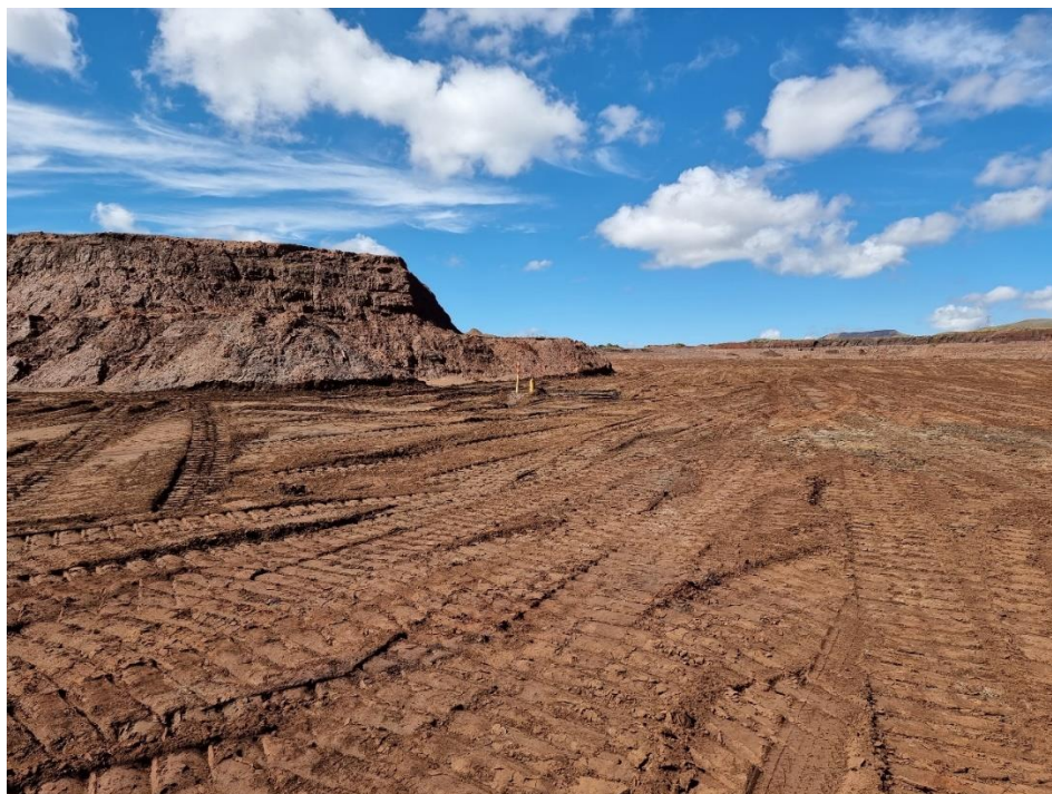
FOTO 14 – B1PZC02, posicionada na porção central da barragem, em porção em retomada, coordenadas 611536.7m E, 7760318.8m N e Elev. 1269 m. Este instrumento, inicialmente com 32 m, atualmente conta com apenas 13 m, confirmando que cerca de 20 m da barragem foram retomados. Leitura de nível d'água com 7 m de profundidade, indicando saturação no contato rejeito/fundação.
