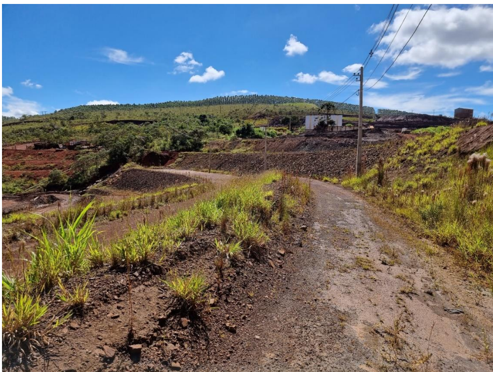
FOTO 26 – Bancada na elev. 1257 m. A drenagem superficial é realizada por controle topográfico, inexistindo quaisquer evidências de mal funcionamento. Todas as praças contam com leira de proteção adequada.
