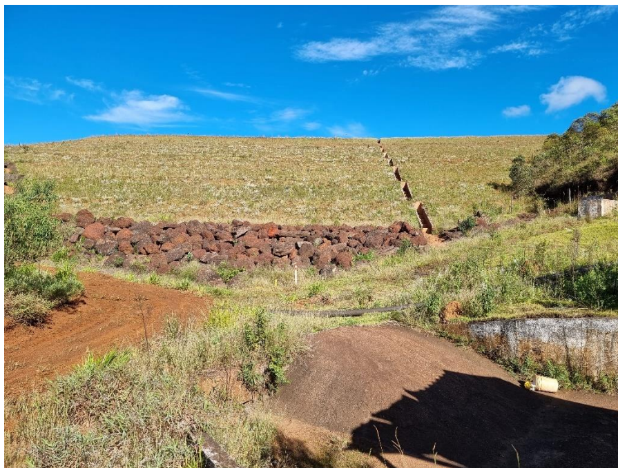
FOTO 51 – Vista geral do talude de jusante da barragem B4, a partir do pé da estrutura. Verifica-se boa conformação geométrica dos bancos, com sistema de drenagem superficial na porção central da estrutura, em escada de descida d’água em concreto armado. No pé da estrutura, enrocamento de canga.
