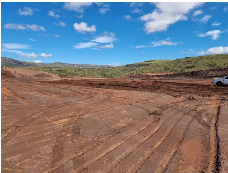
FOTO 11 – Outra vista da bancada El. 1264 m, nas proximidades da ombreira direita da estrutura. Conforme pode ser observado, a praça encontra-se regularizada. À medida que os cortes são executados é realizado o rebaixamento dos instrumentos.
