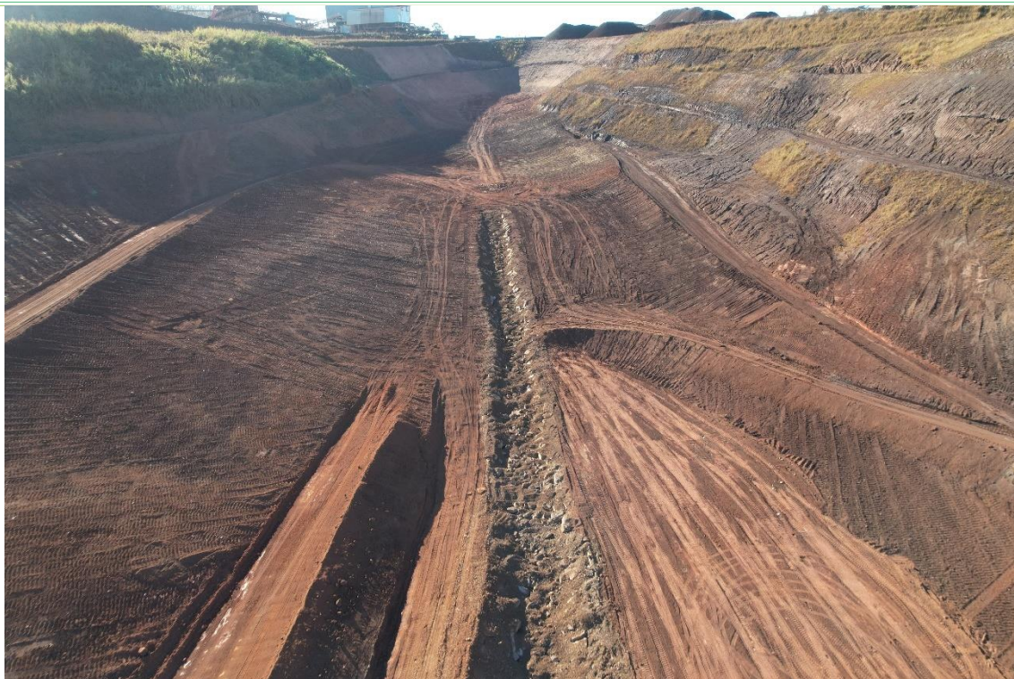
Figura 27 - Taludes escavados junto ao antigo reservatório da Barragem B1 (fundo do reservatório).
