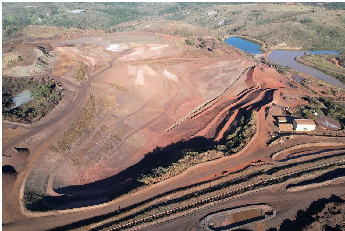
Figura 28 - Visão geral da Barragem B1. Vista de montante para jusante.
