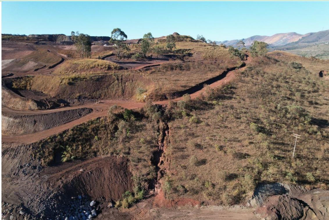
Figura 17 - Visão da ombreira esquerda do dique de partida da barragem B1.
