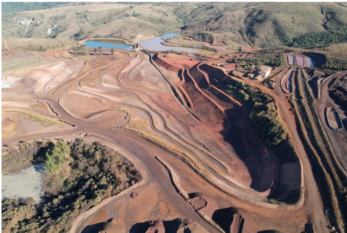
Figura 30 - Visão geral da Barragem B1. Vista de montante para jusante.
