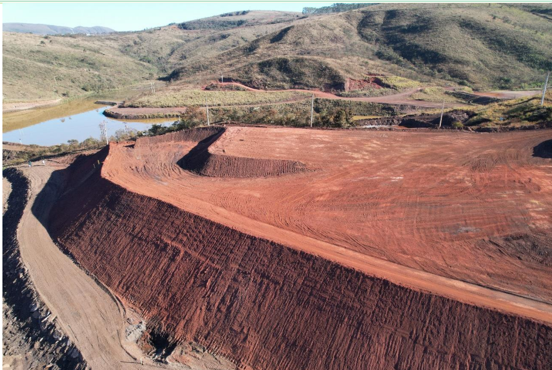
Figura 25 - Taludes escavados junto ao antigo reservatório da Barragem B1 (ombreira direita).
