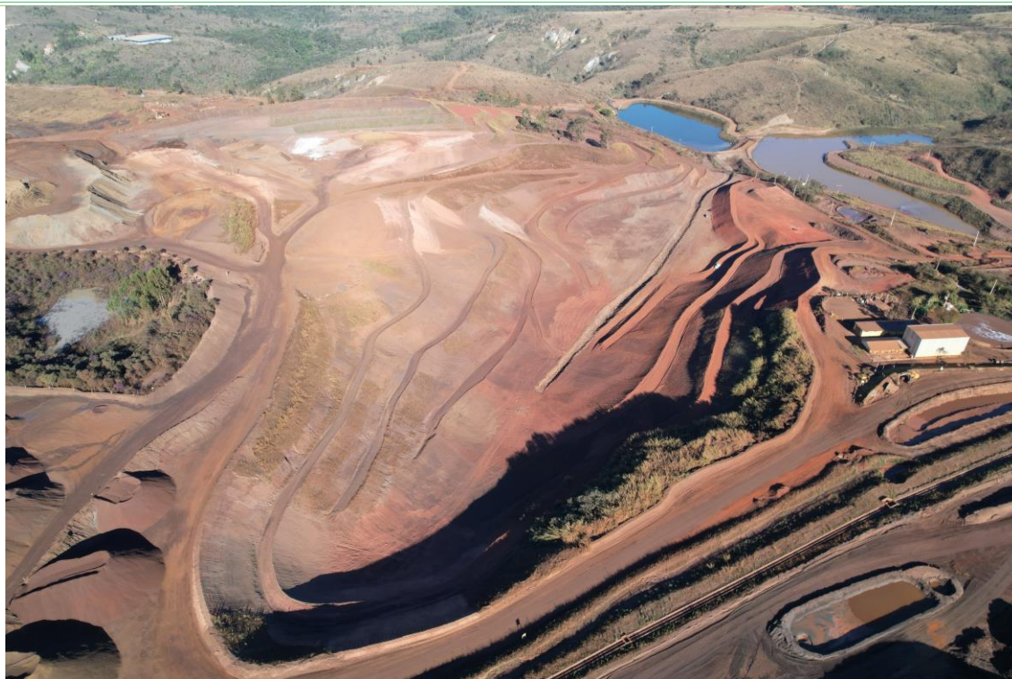
Figura 5 - Região da barragem B1 e do Dique da Barragem B1.
