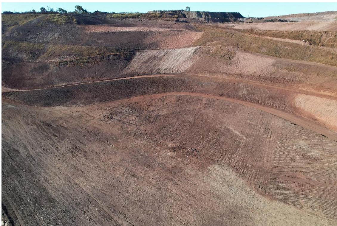
Figura 22 - Taludes escavados junto ao antigo reservatório da Barragem B1 (ombreira esquerda).
