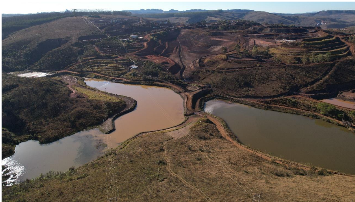
Figura 15 - Visão geral da Barragem B1. Vista de jusante para montante.
