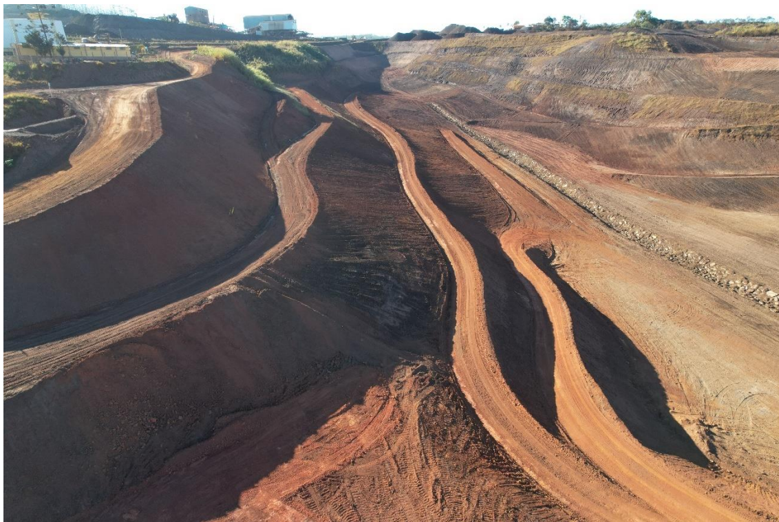
Figura 26 - Taludes escavados junto ao antigo reservatório da Barragem B1 (ombreira direita).
