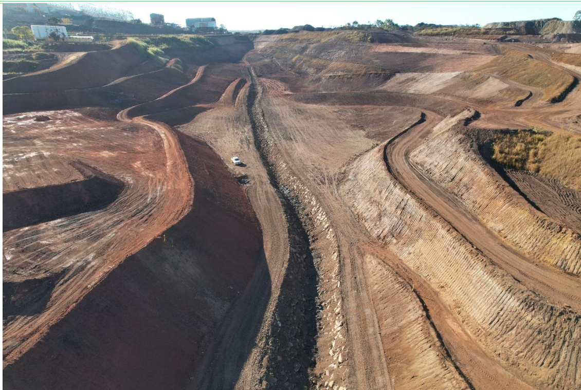
Figura 21 - Canal enrocado de fundo de vale da barragem B1.
