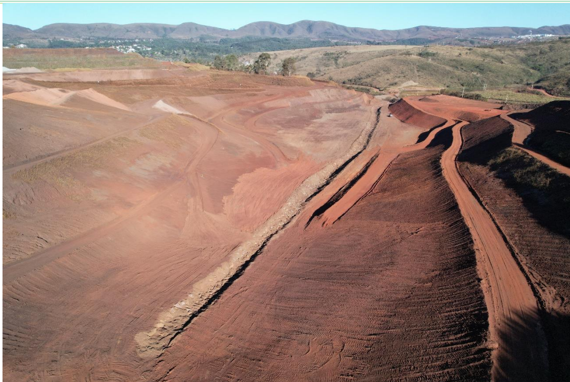
Figura 19 – Emboque do canal enrocado de fundo de vale da barragem B1. Vista de montante para jusante.
