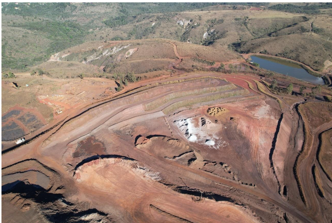
Figura 32 - Visão geral do dique da Barragem B1. Vista de montante para jusante.
