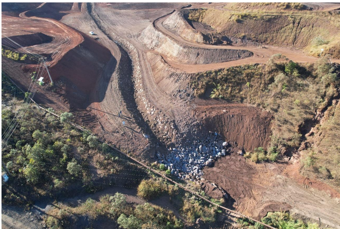
Figura 18 – Desemboque do canal enrocado de fundo de vale da barragem B1.
