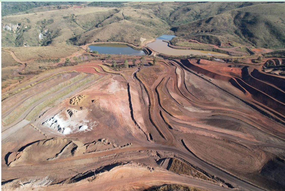
Figura 31 - Visão geral da Barragem B1 e do dique da Barragem B1. Vista de montante para jusante.
