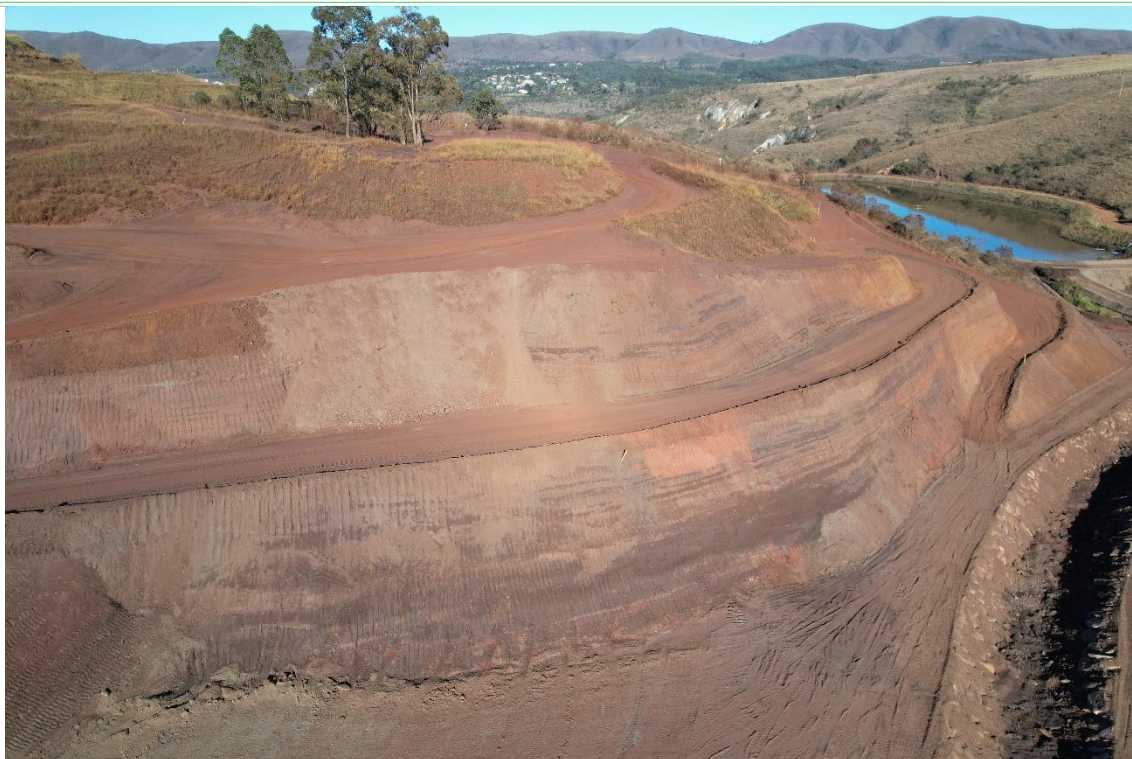
Figura 23 - Taludes escavados junto ao antigo reservatório da Barragem B1 (ombreira esquerda).
