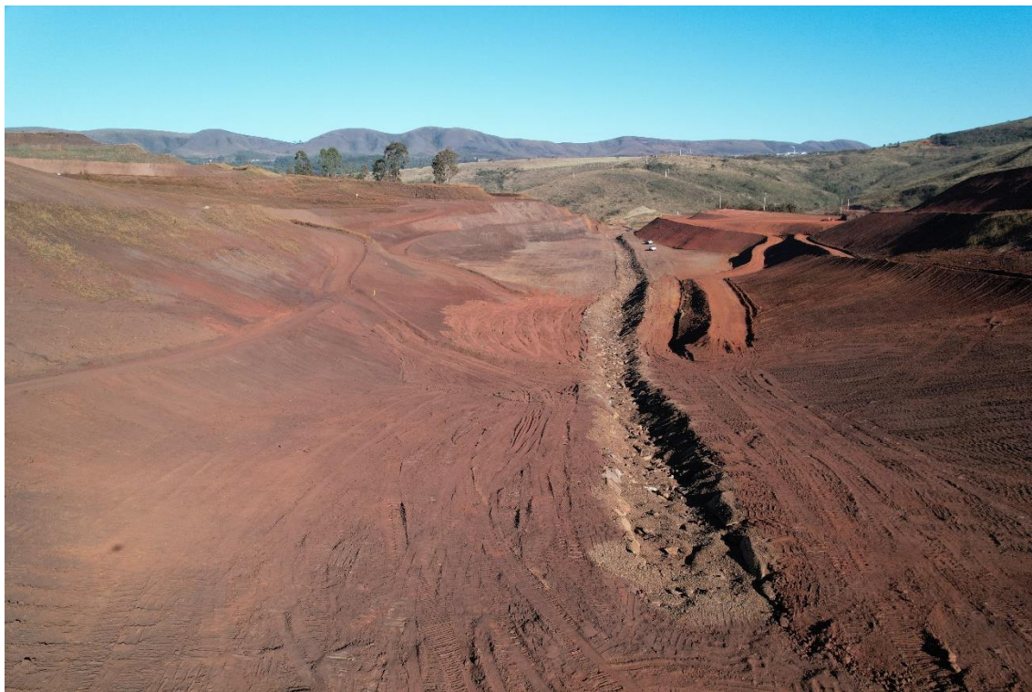
Figura 20 – Emboque do canal enrocado de fundo de vale da barragem B1. Vista de montante para jusante.
